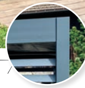
Descente d'eau pluviale intégrée dans les poteaux
